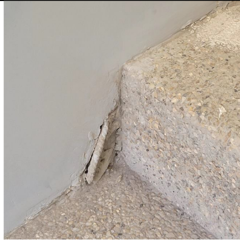
Foto 6. Acabados imperfectos en escaleras de servicio, corredores y bordillos interiores
