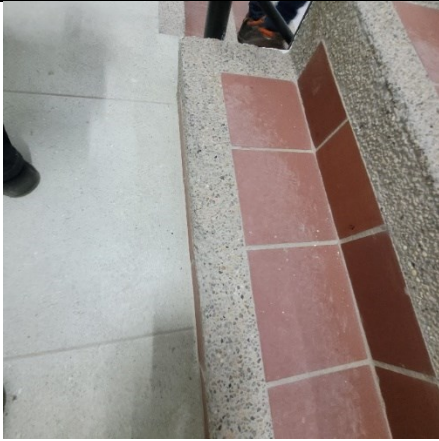
Foto 5. Bordillo de escaleras desportillados
