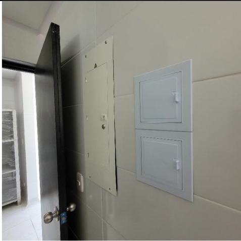
Foto 5. Tableros eléctricos a desnivel
