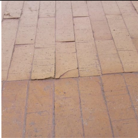
Foto 9. Piso en adoquín en desnivel e imperfectos
