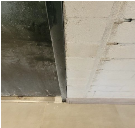
Foto 3. Emboquiles vacíos imperfectos en todo tipo de remate.
