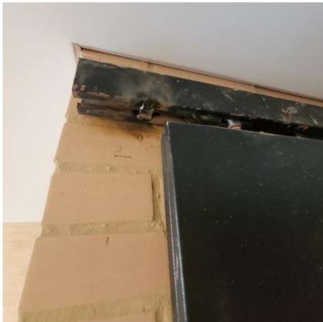
Foto No. 11. Acabados y empalmes de carpintería metálica deficientes
