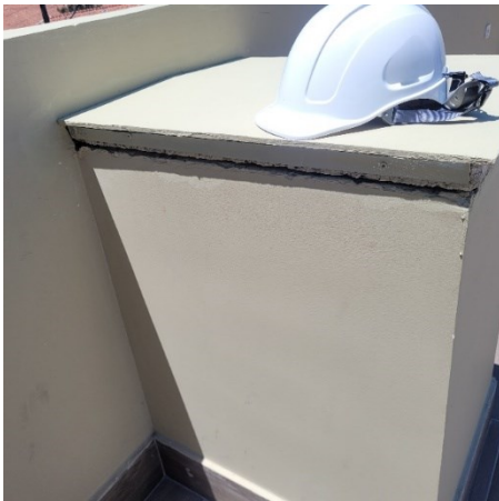
Foto No. 17. Remate deficiente en tapa de ducto de ventilación
