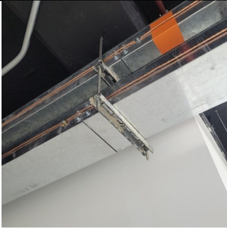
Foto No. 19. Redes y soportes de redes manchados de pintura y sucios
