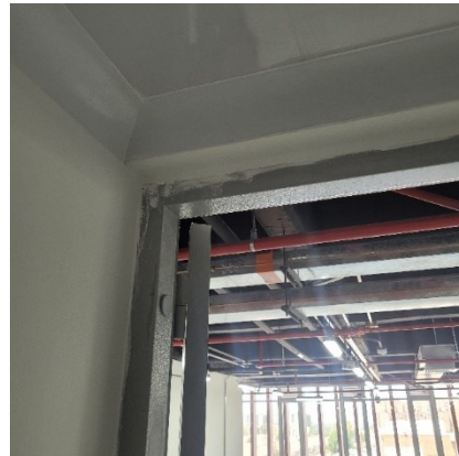
Foto 4. Remates en techos y placas sin terminar
