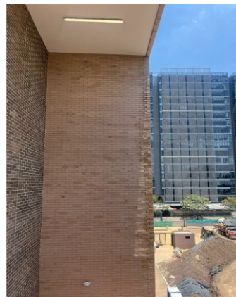
Foto No. 16. Desniveles y acabados de fachada en mampostería deficientes
