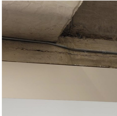
Foto No. 8. Fisuras en placa
