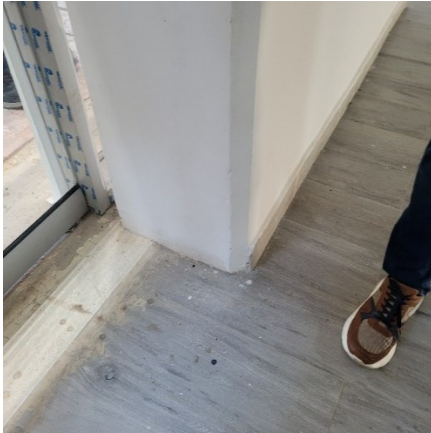
Foto No. 1. Remates deficientes en muros
