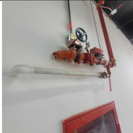
Foto No. 20. Redes y soportes de redes manchados de pintura y sucios
