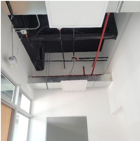
Foto No. 21. Redes y soportes de redes manchados de pintura y sucios
