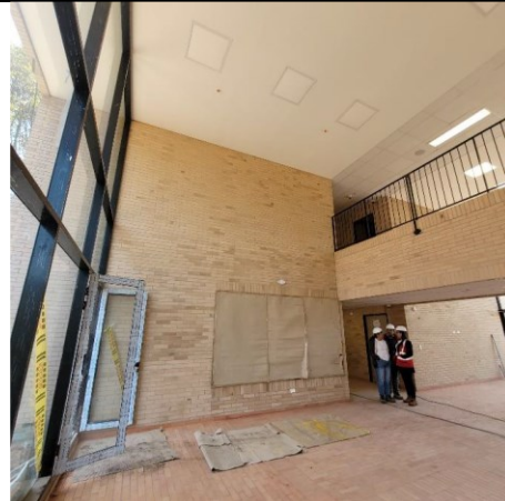
Foto No. 10. Instalación de mampostería en muros internos manchada
