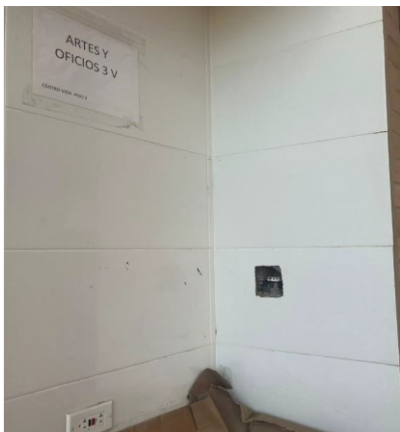
Foto No. 15. Instalación de enchapes en paredes con lotes diferentes
