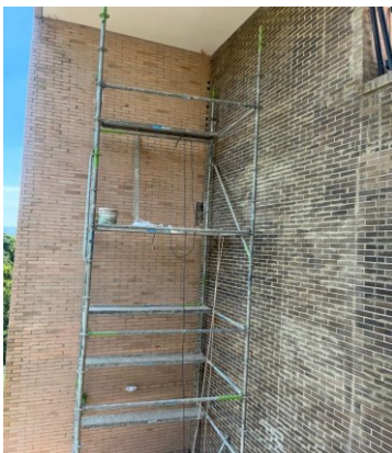
Foto No. 15. Instalación de enchapes en paredes con lotes diferentes
