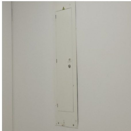
Foto No. 18. Tableros eléctricos en desnivel y mal instalados
