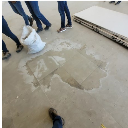
Foto 4. Presencia de humedad, cambios y diferencia de tonalidades en piso cerámico.
