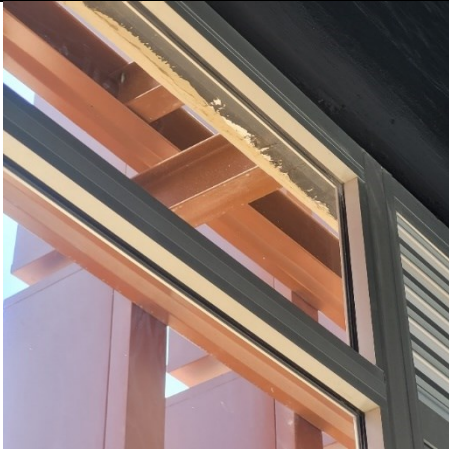
Foto No. 15. Remates externos deficientes
